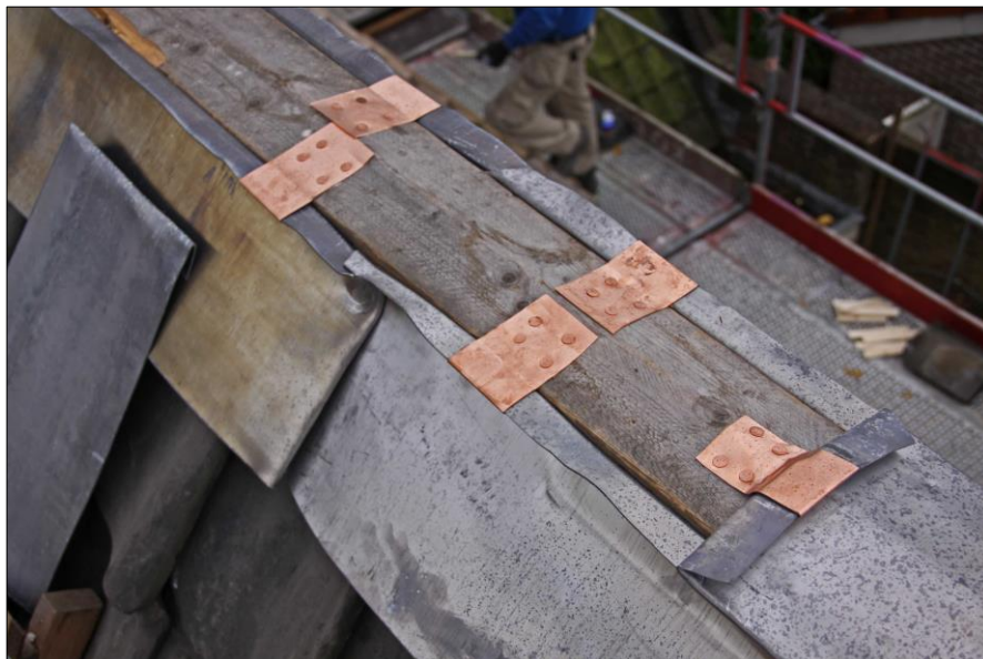
Noklood aangebracht in 3 delen van 25 kg/m 2 , vastgezet met koperen klangen. De delen zijn in lengtes van 1,0 meter verschervend aan elkaar gefelst.
