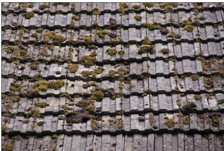
Dakvlak gedekt met cement muldenpannen. De worden op den duur poreus, wat de levensduur beperkt.
