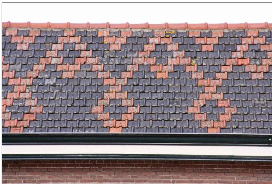
Kruispannen in patroon gelegd. Bij het repareren is het belangrijk dat het patroon hersteld wordt of zichtbaar blijft.
